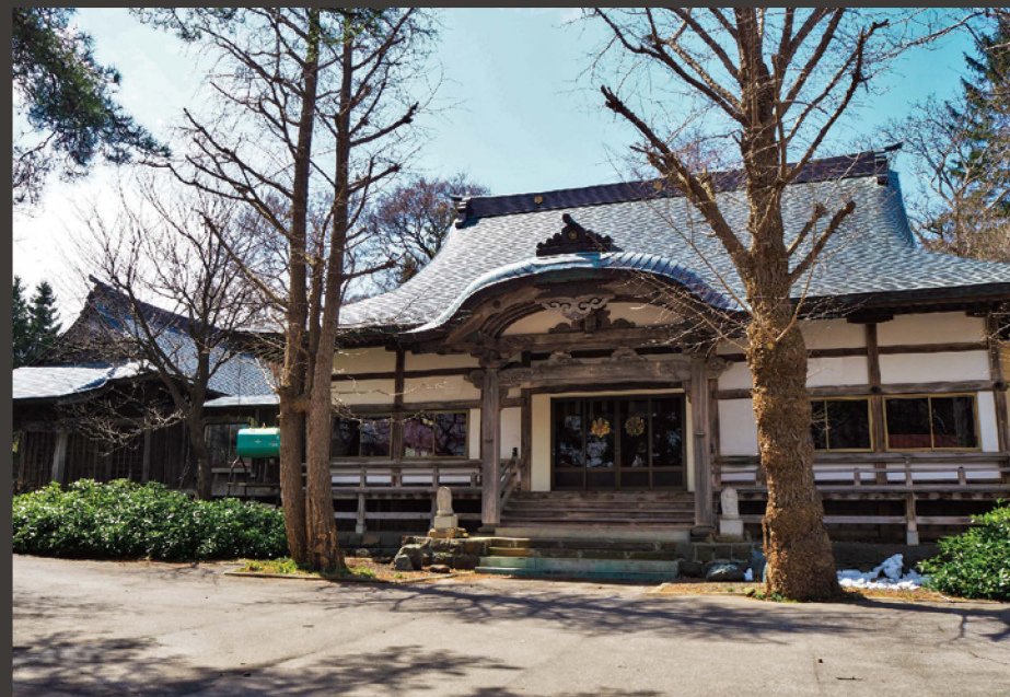
徳源寺本堂。入母屋屋根、平入り（建物表面の垂直方向に入口を設置する方法）で、正面中央に唐破風をつける。本堂内の位牌堂は秋田式といわれる。
