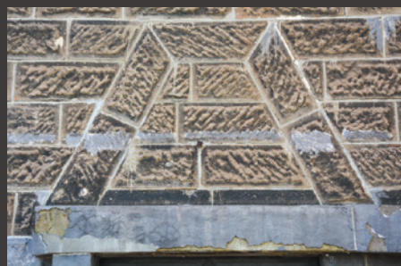
正面右手の扉の上部は台形型に軟石が積まれている。
