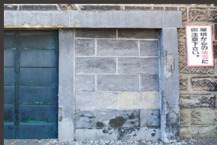
正面右側の扉。軟石が補修されている。
