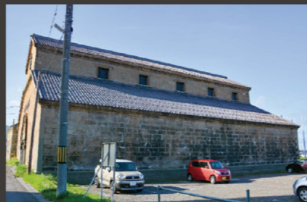
倉庫南側。越屋根の採光窓が特徴的。屋根瓦は北一硝子の関連会社が購入後、復元された。
