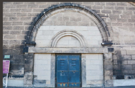
正面右手の二重アーチ。トラック荷役のためシャッターとなっていたが、復元された。
