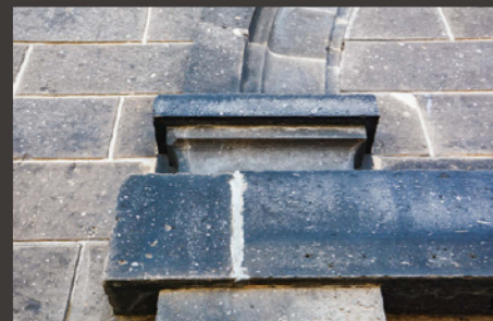
二重アーチの下部の幾何学的な柱型。外観に軽快な印象を与えている。
