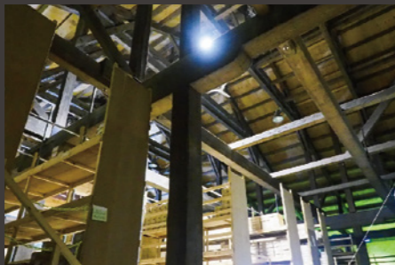
倉庫内部。補修時に木骨が追加された。
