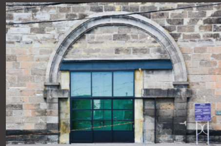
正面(海側)の扉。
