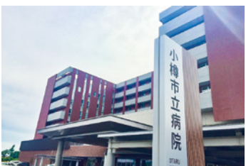
小樽市立病院外観。
