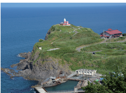
図2：日和山灯台。昭和28年、現在の建物に改築。
