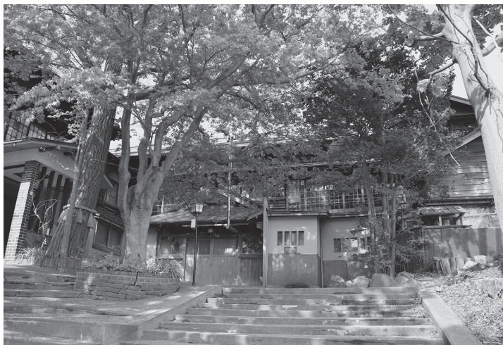
旧魁陽亭の正面（平成30年6月撮影）
