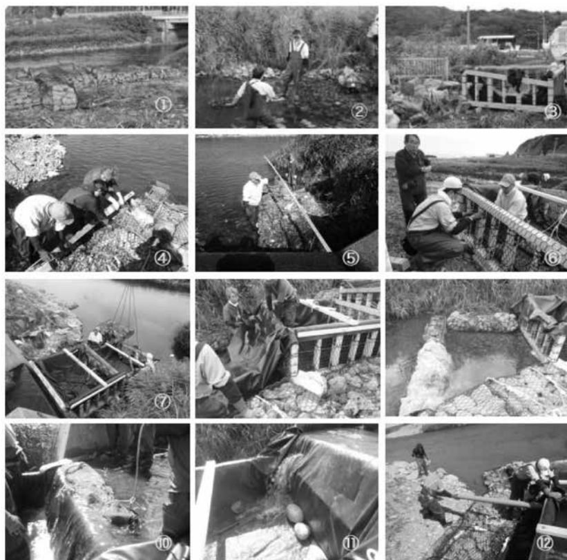
写真6：階段魚道 TypeⅣ 設置工程（余別新川河口現地作業）
