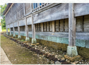
笏谷石 佐藤家の基礎石(二段目)、東石などに使用されている。
