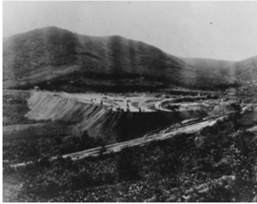
整地作業 (小樽市総合博物館所蔵)
