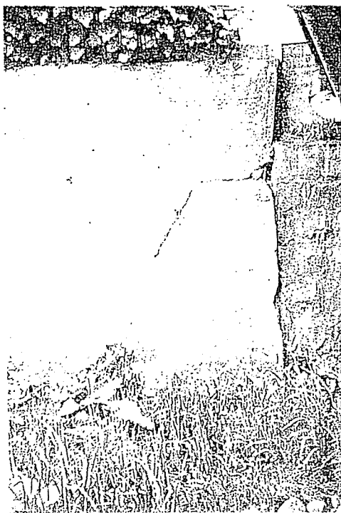
もたれよう壁護岸。亀裂が見られる。
